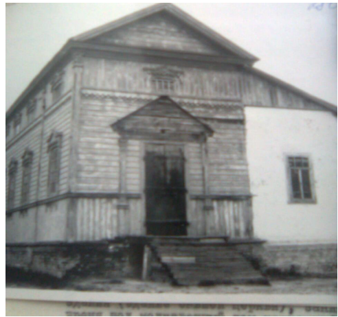
Будівля колишньої церкви, переобладнана під сільський клуб в селі Іванівка, Охтирський район, Сумська область, 1951 р. (ЦДАВО України. — Ф. 4648. — Оп. 1. — Спр. 73. — Арк. 280.)
