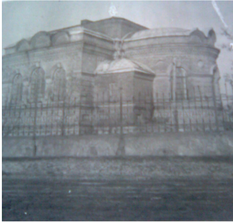
Будинок церкви, переобладнаний під клуб, село Сурсько-Литовське, Дніпропетровська область, 1951 р. (ЦДАВО України. — Ф. 648. — Оп. 1. — Спр. 69. — Арк. 200.)
