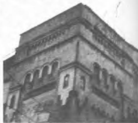
Западная часть фасада ликероводочного завода. Фото автора. 2008 г.
