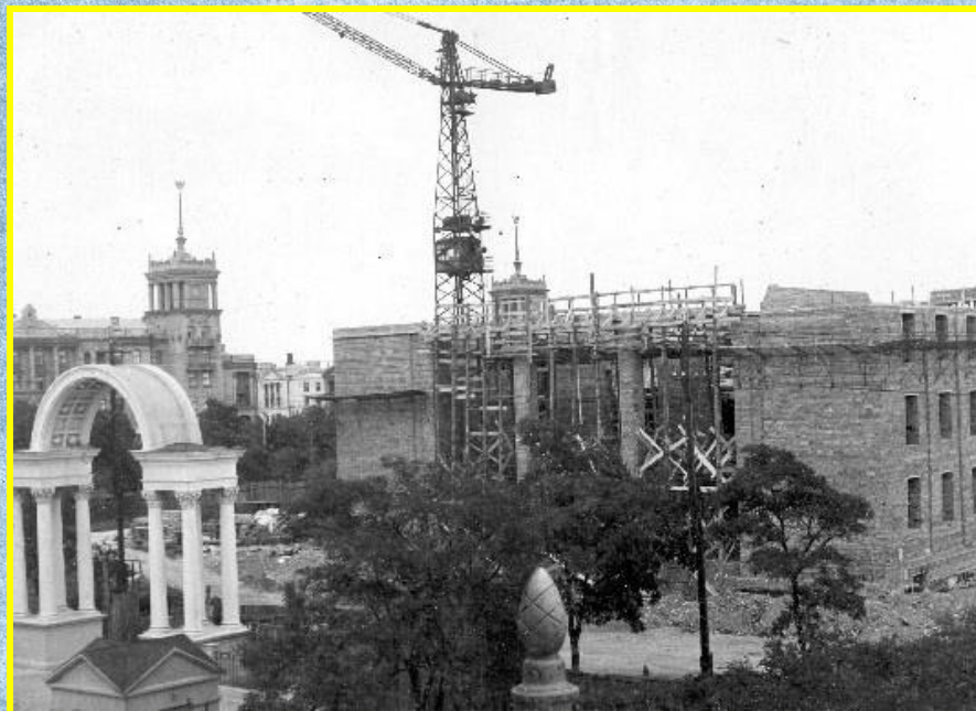
Будівництво театру Кінець 1950-х рр. («Весь Мариуполь», с. 149)
